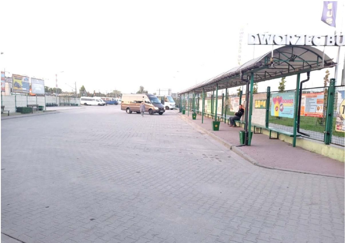
Fot. 2. Płyta Dworca Bus i stanowiska odjazdowe;
