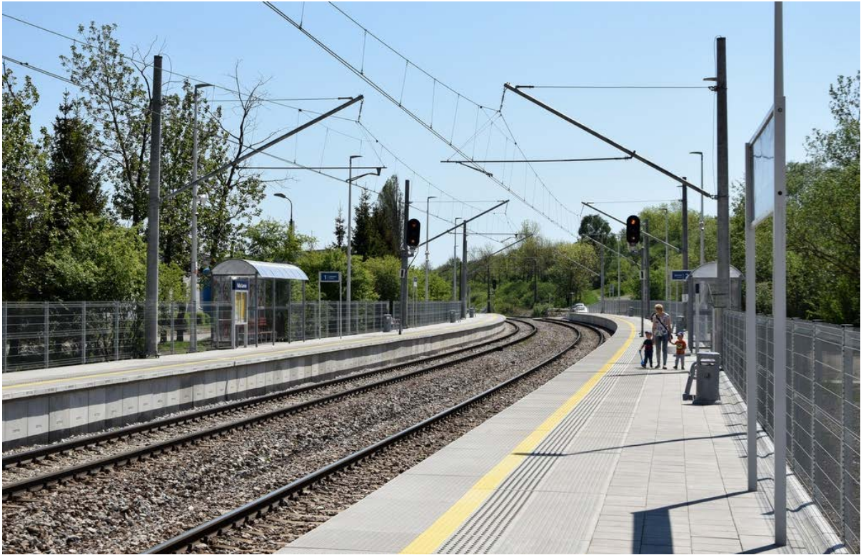
Fot.5. Przystanek kolejowy Kielce Ślichowice; Źródło: semaforek.kolej.org.pl (dostęp 27.05.21)
